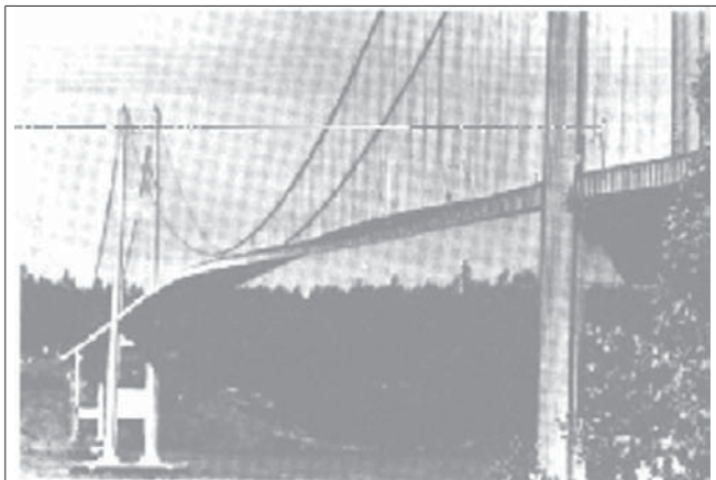
Pont de Tacoma Narrow quelques instants avant sa rupture
